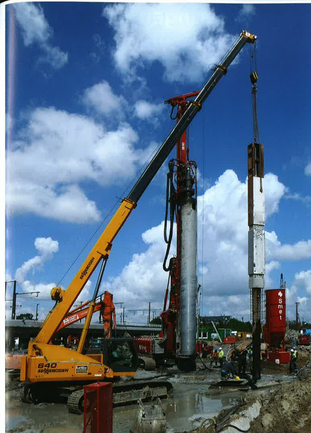
Van Laere bouwt de ondergrondse parking zonder eerst een diepe bouwput te hebben gegraven. Aan het uitgraven van de parking gingen onder meer het storten van zijwanden en dakplaat en het boren van clusterpalen vooraf.
